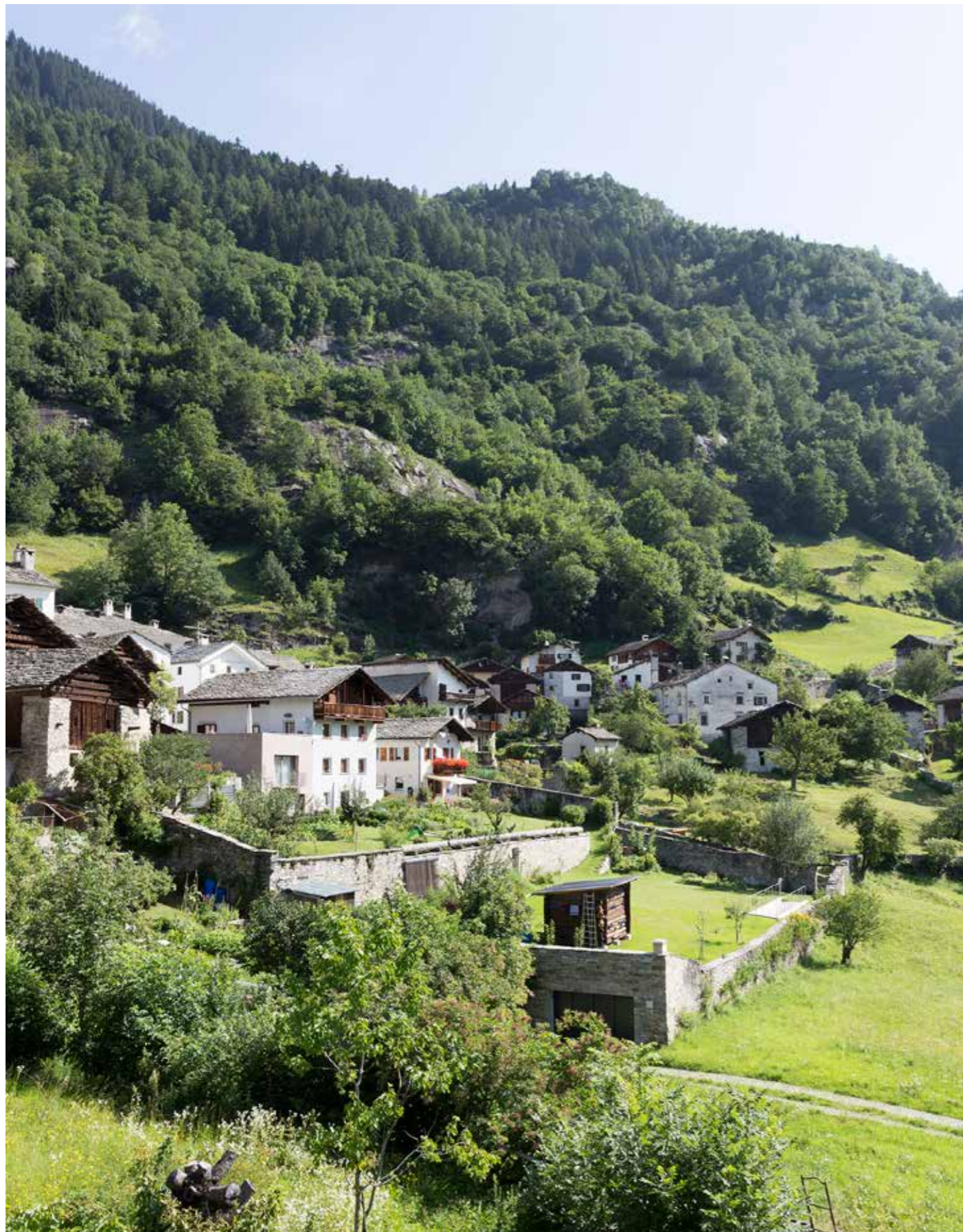
À Soglio (GR), un parking souterrain a été intégré avec beaucoup de doigté dans la zone de jardins. Les murs de pierres sèches d'origine et la voie d'accès non goudronnée réduisent l'impact visuel de l'infrastructure sur la localité.
