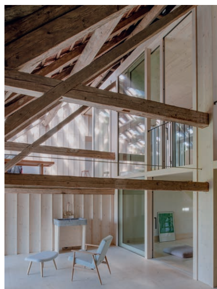
Transformation en habitation d'une ferme protégée à Cottens (FR).
