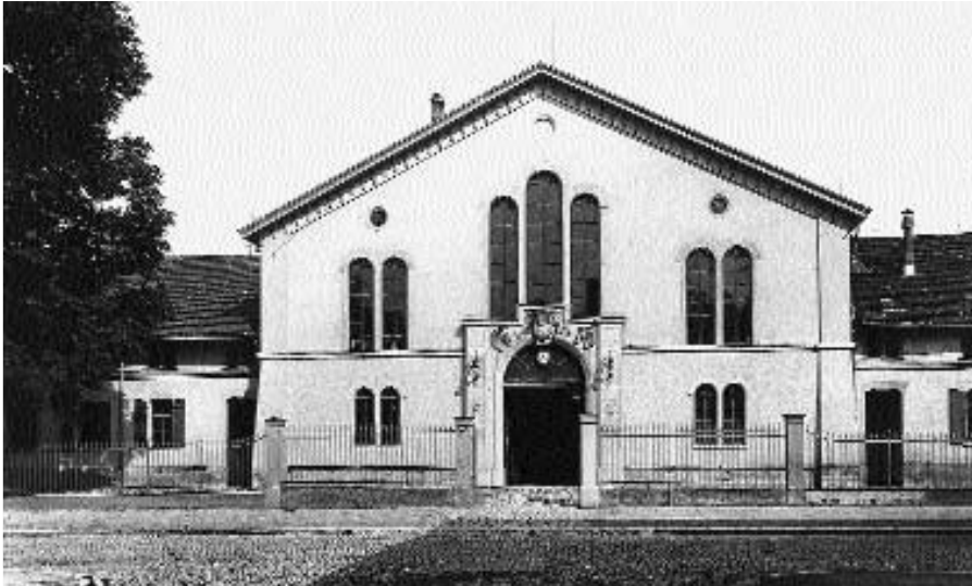
Stirnfassade der grossen Reithalle (jetzt Theaterhaus Gessnerallee), flankiert von den Stallungen am Schanzengraben.
