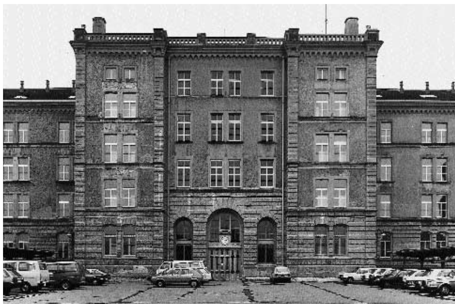
Fassade des Mitteltrakts am Kasernen-Hauptgebäude gegen die Exerzierwiese.
