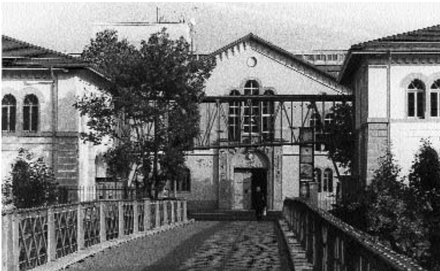
Oben links: Ehemalige Stallungen (mit neuer Passerelle) an der Sihl mit der Militärbrücke im Vordergrund; in der Mitte hinten die ehemalige grosse Reithalle.
