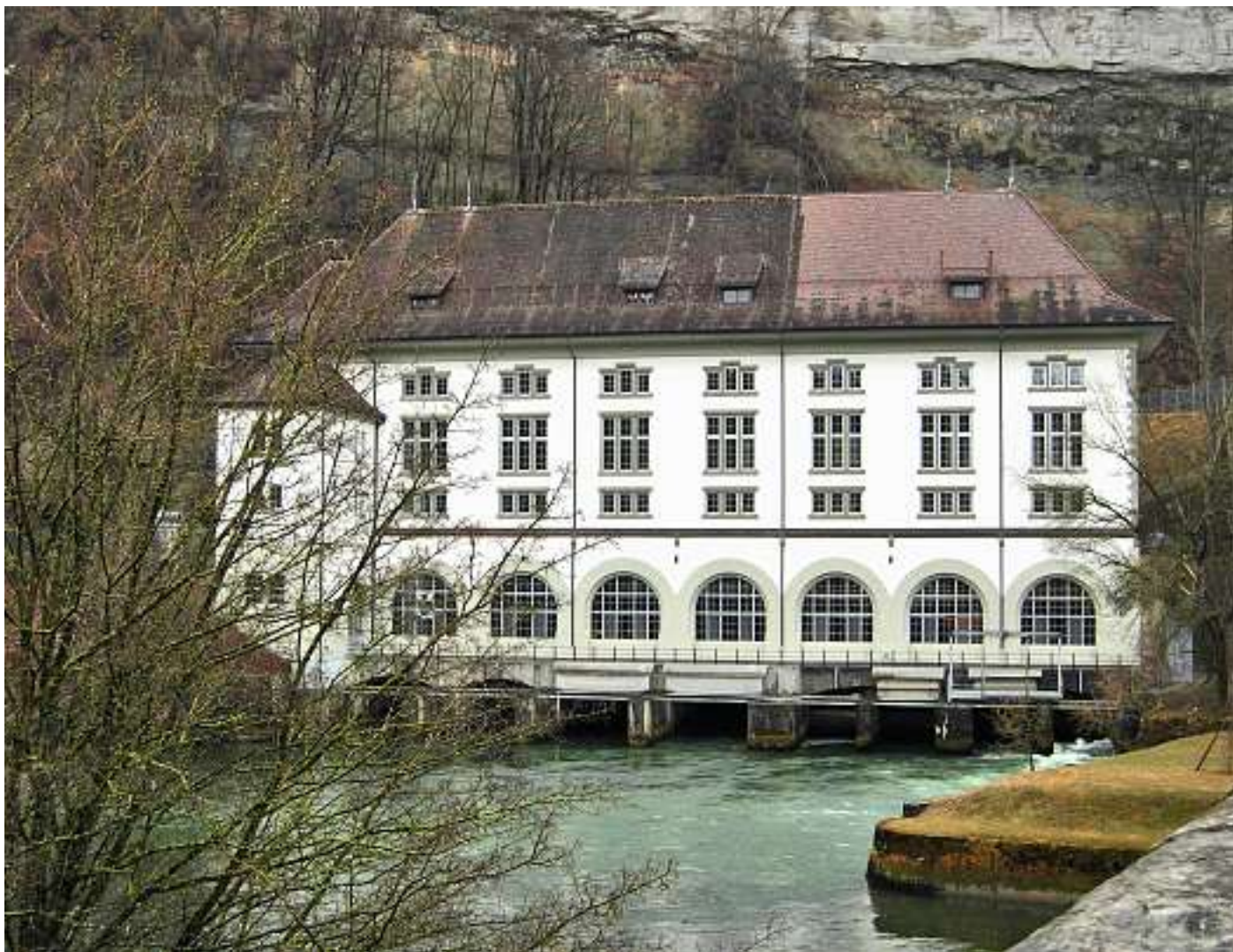
Lors des Journées européennes du patrimoine, l'usine électrique de l'Oelberg (1910) près de Fribourg, alimentée par l'eau de la Sarine, sera ouverte au public. (photo Service des biens culturels, Fribourg)
