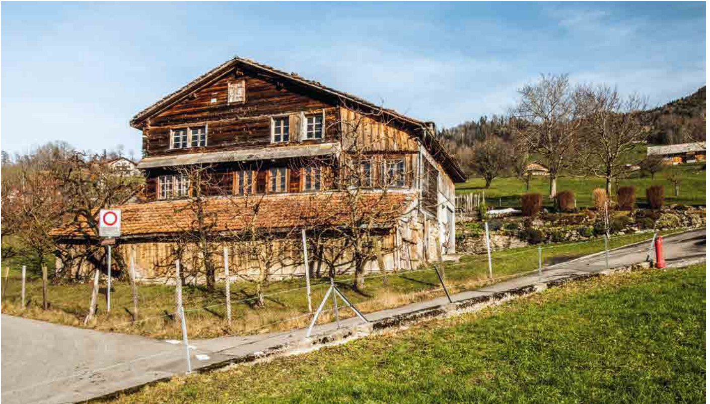
Das Holzhaus in Steinen SZ im Januar 2018 – einer der ersten Fälle auf der neuen Roten Liste des Schweizer Heimatschutzes La maison médiévale de Steinen (SZ) en janvier 2018 – un des premiers objets de la nouvelle Liste rouge de Patrimoine suisse
