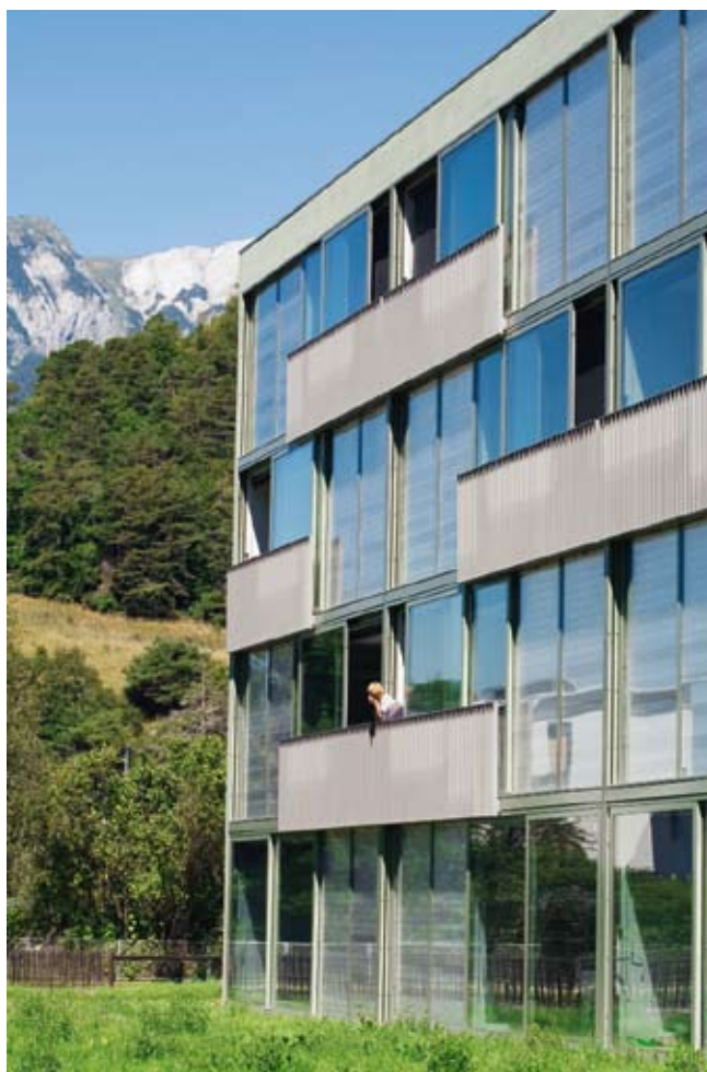
Logements pour personnes âgées à Domat/Ems (bureau d'architecture Dietrich Schwarz). Les grandes fenêtres côté sud constituent le cœur de l'approvisionnement en chaleur. Des capteurs solaires d'une surface de 22,5 m 2 et deux pompes à chaleur air/eau fournissent le solde de calories. Ce bâtiment innovatif a reçu le Prix solaire 2006 (photo Ps)
