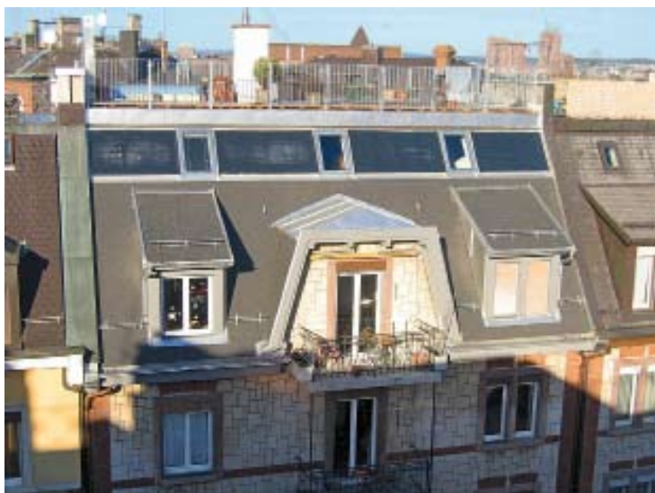
Sorgfältig ins Dach eingefügte Solaranlage zur Warmwasseraufbereitung in Zürich (Bild Stadt Zürich)
