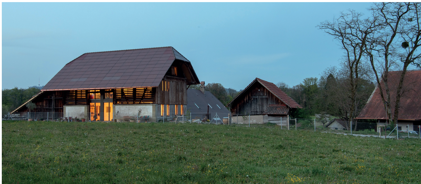
Weyerguet, Wabern BE, Halle 58 Architekten GmbH. (Image: Christine Blaser, Bildaufbau)
